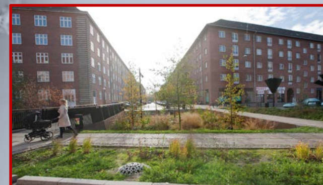
Registrering af LAR-anlæg
